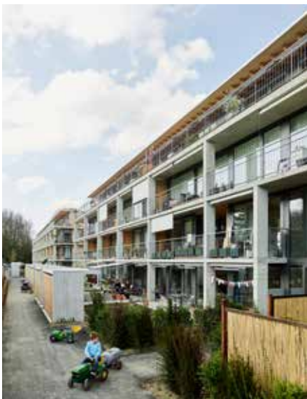
Die Erdgeschosswohnungen sind über einen Ausseneingang sowie den Keller zugänglich. In Haus B können sie mit einem Atelier im Untergeschoss gekoppelt werden.
